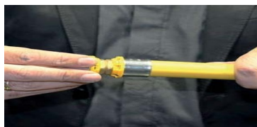
Paso 3: introducir el tubo en la pieza, comprobando a través de los orificios del anillo plástico que sujeta el casquillo de acero inoxidable que ha llegado al final.
