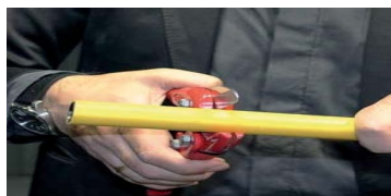
Paso 1: realizar un corte perpendicular al eje de la tubería multicapa GPF GAS
