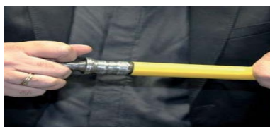
Paso 2: calibrar el interior del tubo y escariar interiormente 1 mm para diámetros de 16 a 25, y 2 mm para diámetro 32.
